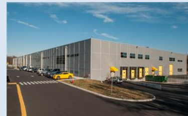
IGUS Warehouse (NY, US)
